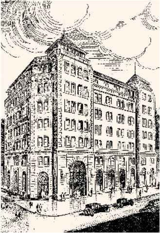
Plumilla del Edificio del Banco Central Hipotecario.
